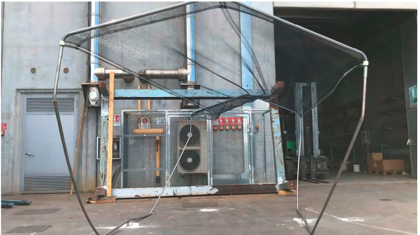
Fotografia dell'oggetto al termine della prova, leggermente deformato ma integro
